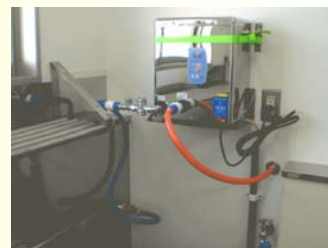
オゾン水機(BT-01)。車庫内に持ち込めるように、本体を脱着式に設置しました。
